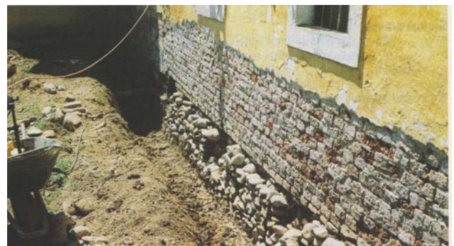
Abgegrabenes Fundament, Foto: "die umweltberatung"
