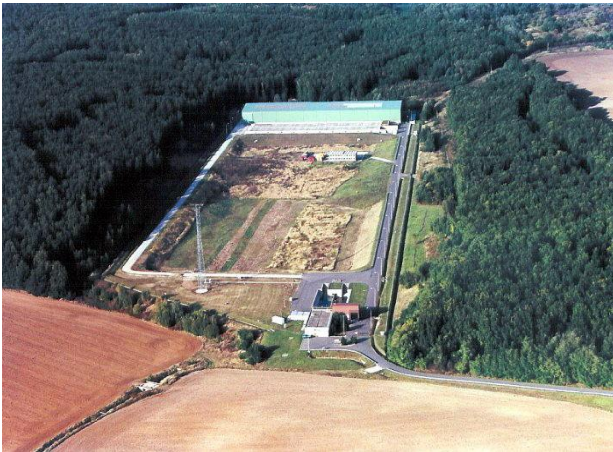
Obr.C-IX. 13 Celkový pohľad na RÚ RAO po dokončení prvého dvojrada
