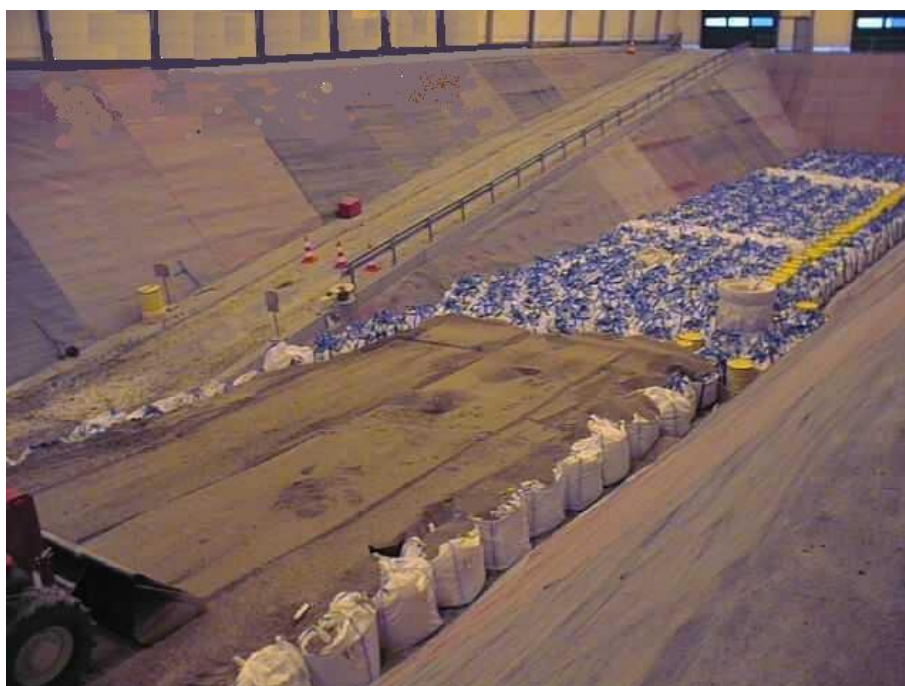
Obr.C-IX. 7 Navážka prekryvnej vrstvy zeminy na 1. vrstvu VNAO na úložisku v Morvilliers [L-110]
