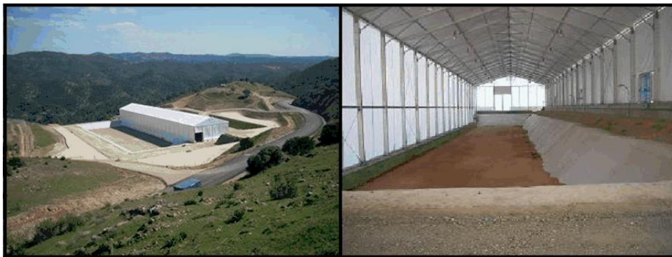
Obr.C-IX. 9 Ukladanie VNAO v pruhoch a odvedenie dažďových a priesakových vôd (španielský prístup)
