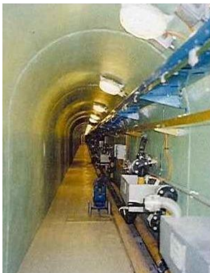
Obr.A-II. 5 Monitorovacia štôlna RÚ RAO Mochovce so systémom kontrolnej drenáže KD1 a KD2
