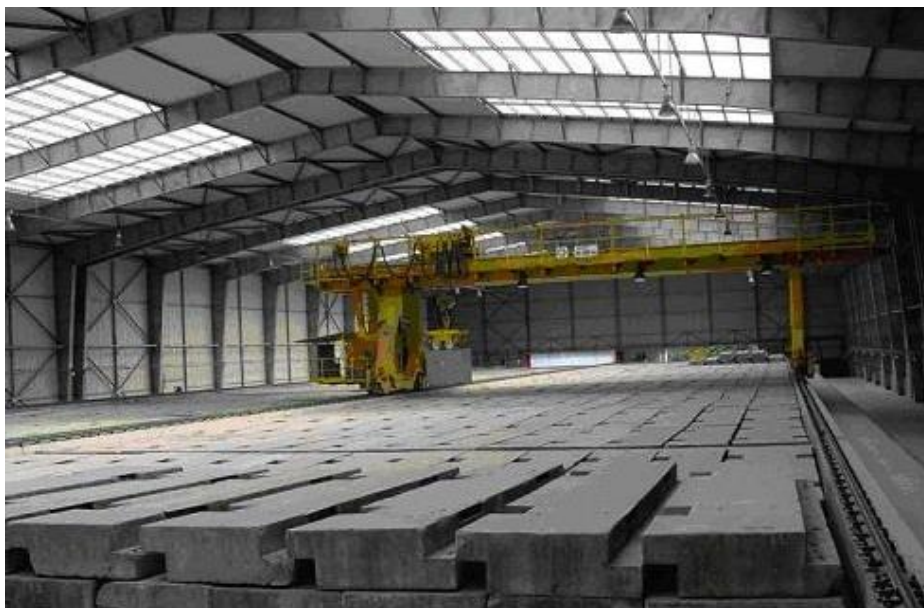
Obr.A-II. 3 Oceľová hala nad 1. dvojradow RÚ RAO s portálovým transportným žeriavom
