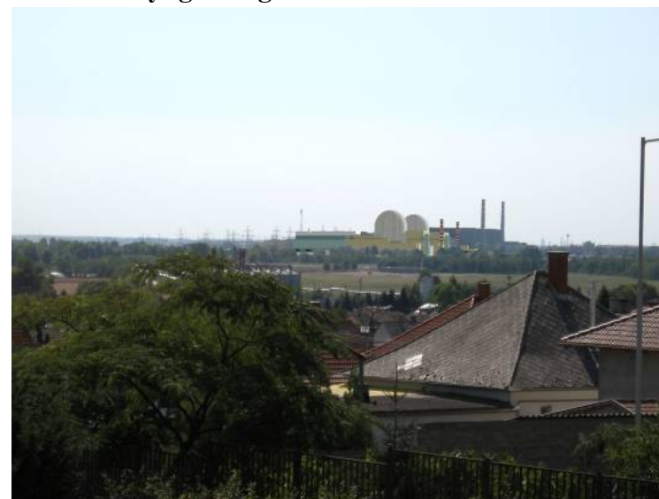
M-26. ábra: Az új APR1400 blokkok az erőmű lakótelep felől
