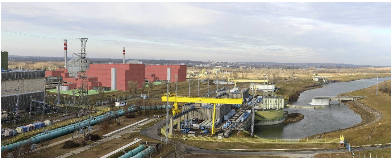
M-22. ábra: Az új EPR blokkok a hidegvíz csatorna nyugati vége felől
