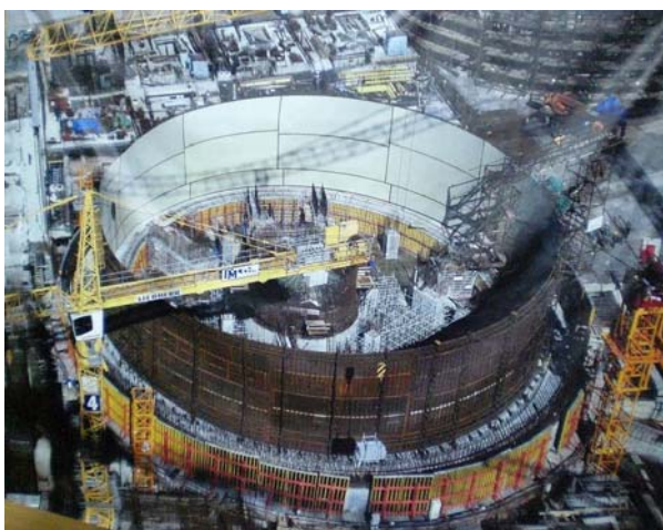
2.4.4.2-1. ábra: Az épülő erőművi blokk Szosznovij Borban
