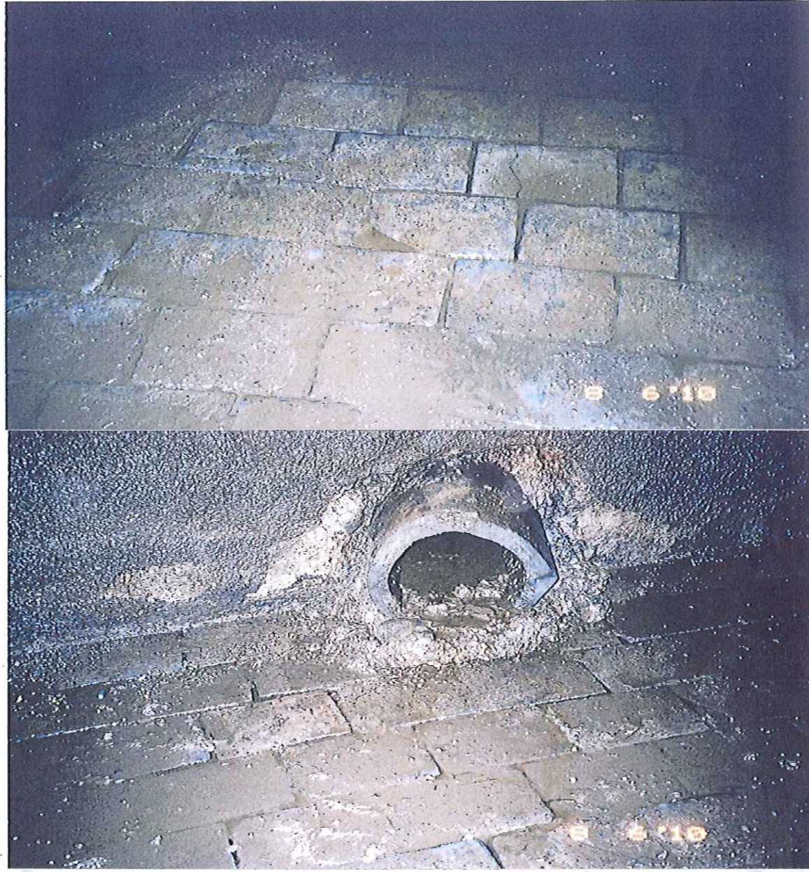
Detailansichten der Abwassergrube
