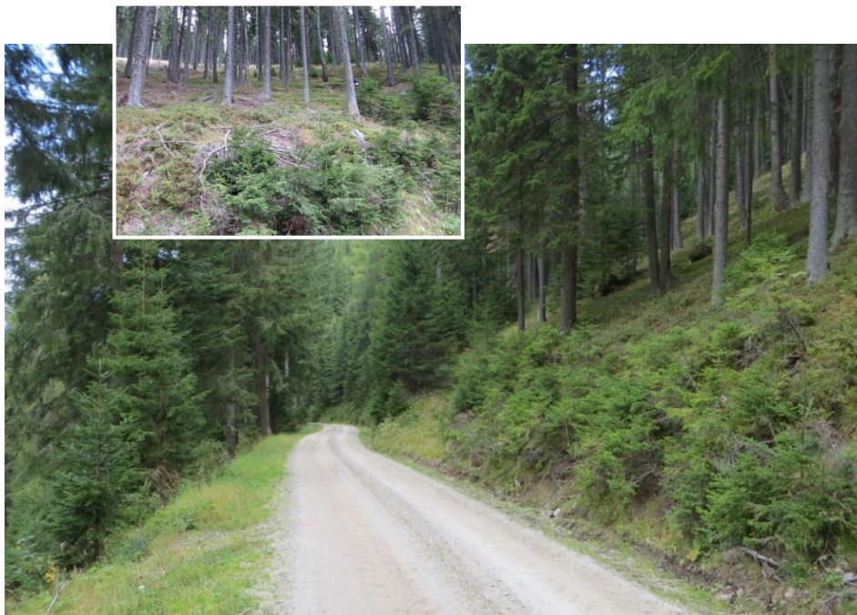
Abbildung 15: Blick auf den relativ flachen Hang bei Ausweichfläche 7. Die Bäume zeigen im zentralen Bereich einen leichten Säbelwuchs an. Das kleine Bild links oben zeigt den Teilbereich in dem die Bäume eine Schiefstellung aufweisen und ein reliktscher Anbruch mit voraussichtlich ruhender Rutschmasse angedeutet ist.
