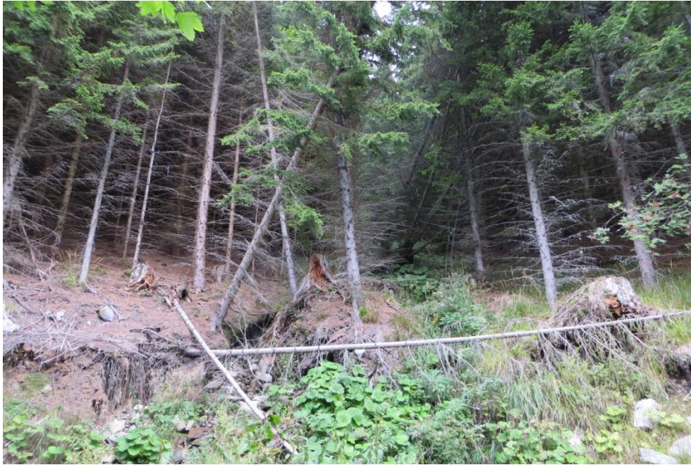
Abbildung 10: Instabilitäten im Nahbereich der Trompete 11. Die Morphologie zeigt flachgründige Anbrüche mit entwurzelter und verkippter Bäumen links und rechtsufrig des Nordost-Südwest verlaufenden Gerinnes.
