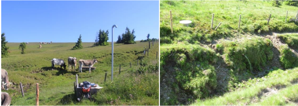
Abbildung 21: Quelle PA_7Q – Wasserversorgung Roseggerhaus. Quellfassung mit Sammelbehälter und Überlauf in den Bach (rechtes Bild).
