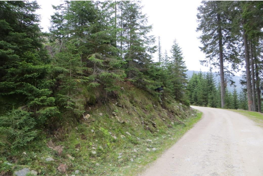
Abbildung 19: Fotoaufnahme beim geplanten Ausweichpunkt A10 zeigt die flache Hangneigung und die zu erwartende, geringe Böschungshöhe nach dem Einschnitt.
