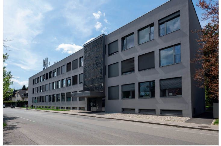
Studentenwohnheim Graz – umfassende Sanierung; © Katarina Paller
