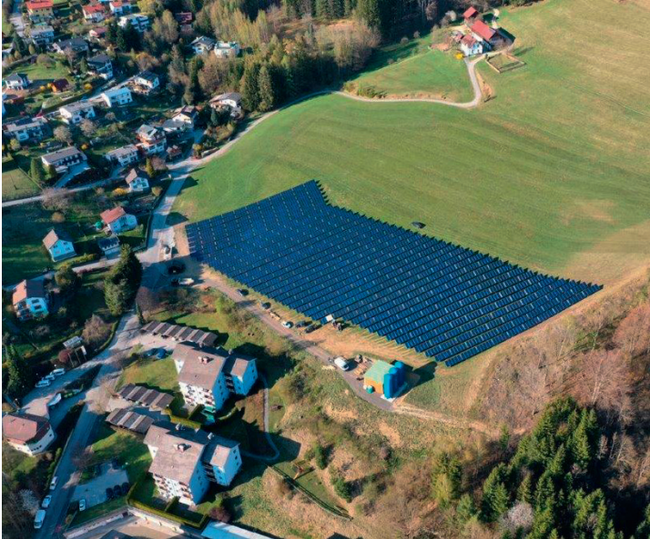
Thermische Großsolaranlage Mürzzuschlag, Luftbild; © SOLID Solar Energy Systems GmbH
