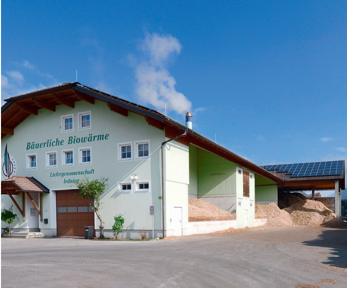
Biowärme Irdning mit Holzlager; © Bäuerliche Biowärmelieferungs-genossenschaft Irdning eGen
