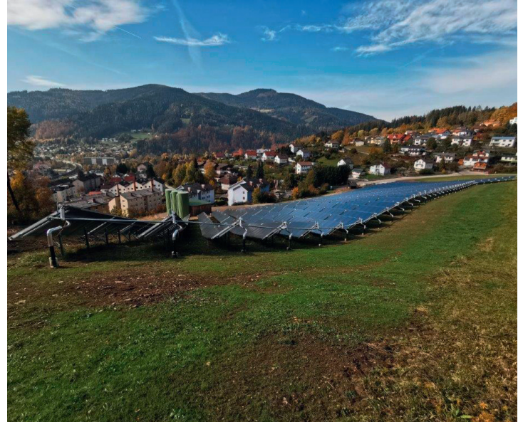
Thermische Großsolaranlage inklusive Pufferspeicher; © SOLID Solar Energy Systems GmbH
