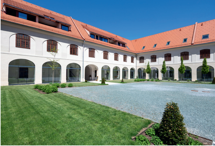
Stärkung des Ortskerns Fürstenfeld – umfassende Sanierung; © Katarina Paller
