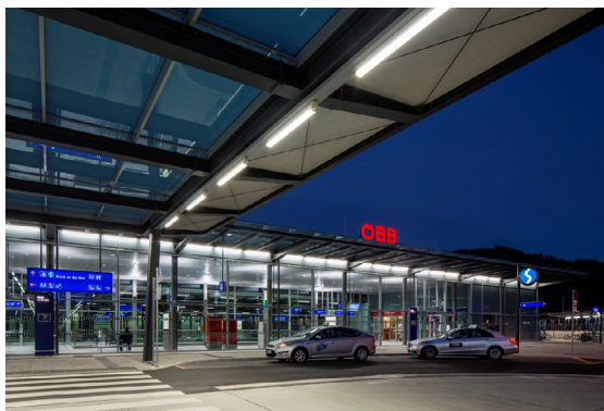
Der neue Bahnhof Bruck/Mur © S-Bahn Steiermark/Luttenberger
