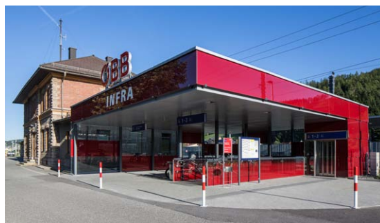
Abb. 9: Der neue Bahnhof Niklasdorf – ready for S-Bahn! © S-Bahn Steiermark/Luttenberger
