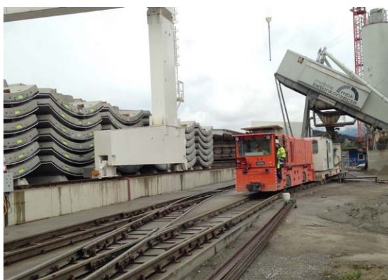
Abb. 14: Koralmbahn Tübbinglager KAT3 © Nagelschmied
