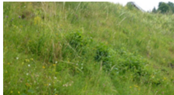
Nach den Arbeiten
