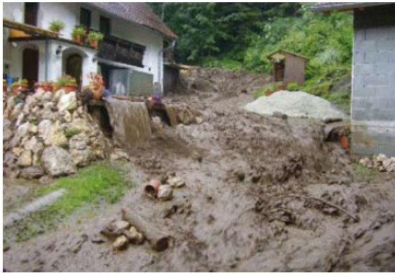
Abb 11 - Versagen von Schutzbauten (Quelle: Land Steiermark, FA13B)
