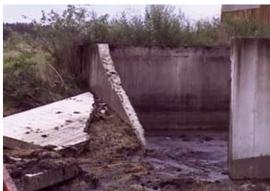
Abb 4: Fast die ganze Betonwand fiel um und 260 m 3 Jauche ergossen sich bergab.
