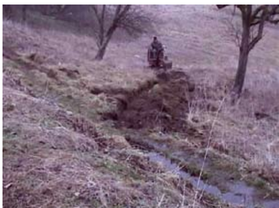
Abb 1: Einsatz eines Minibaggers.
