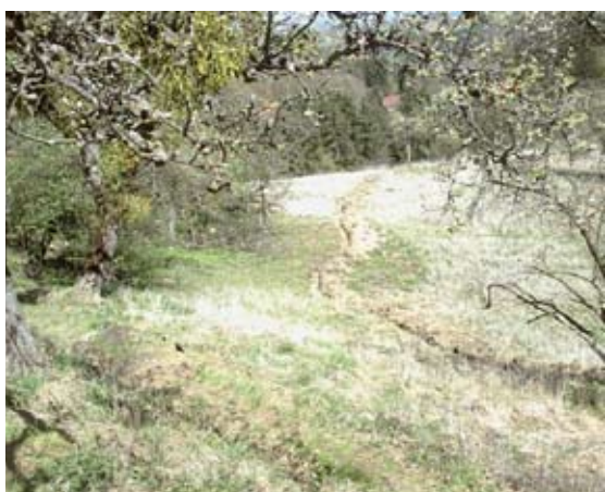
Abb 2: Der fertige Ableitgraben zum Versickern des jaucheverunreinigten Gerinnes auf einer nicht mehr intensiv bewirtschafteten Wiese.
