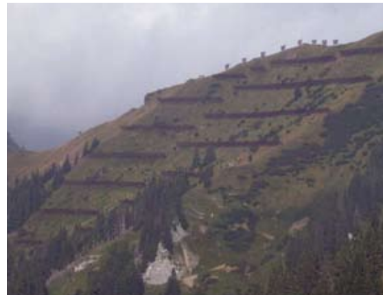
Abb 9: Wiederherstellung der Schutzwirkung mit Hilfe technischer Verbauungen (Rauchkogellawine Pusterwald).
