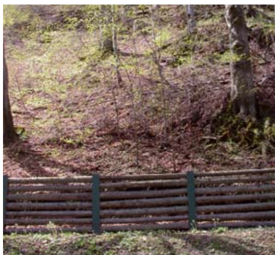
Abb 6: Mangelnde Schutzwirkung des Waldes macht teure technische Verbauungen notwendig.
