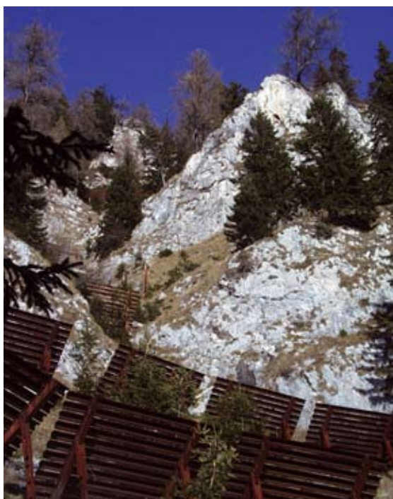
Abb 8: Schutzwaldsanierung in schwierigem Gelände.
