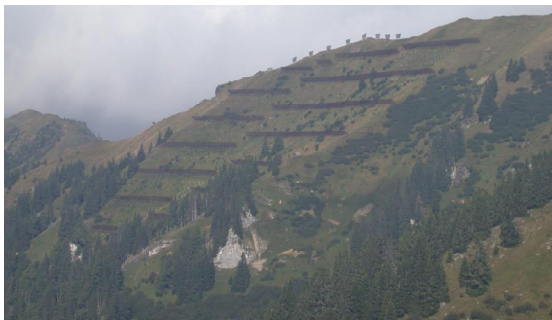
Wiederherstellung der Schutzwirkung mithilfe technischer Verbauungen-Rauchkogellawine Pusterwald
