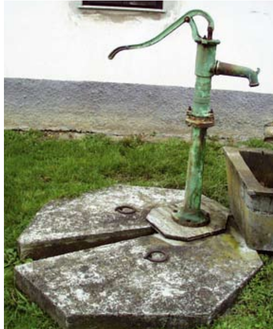
Abb 20: Mangelhafte Brunnenschachtabdeckung.
