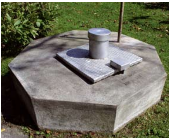
Abb 19: Ordnungsgemäße Brunnenschachtabdeckung.
