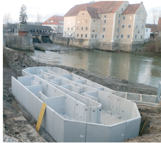
Abb. 8: Technischer Schlitzpass bei dem Kraftwerk Berghofer Mühle für eine Fischpassierbarkeit, © ABT14
