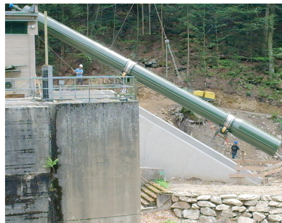
Abb. 9: Stubenberg, Einbau der Schnecke, © ABT14
