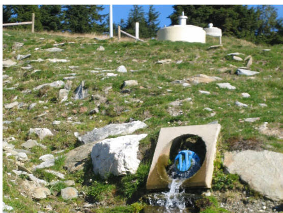
Quellsammelschächte mit gesicherter Ableitung des Überwassers
