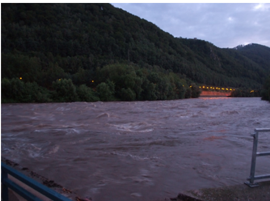
Mur – Stauraum Kraftwerk Weinzödl, Juli 2012
