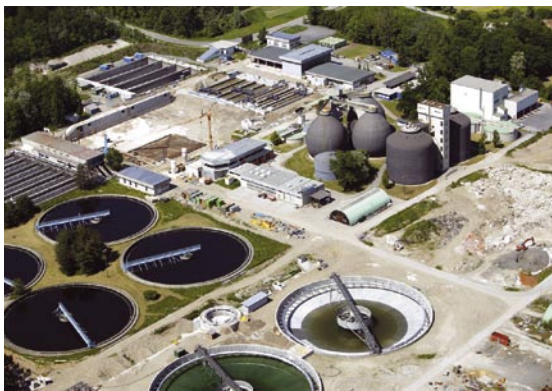
Umbauarbeiten an der Kläranlage Graz 2005
