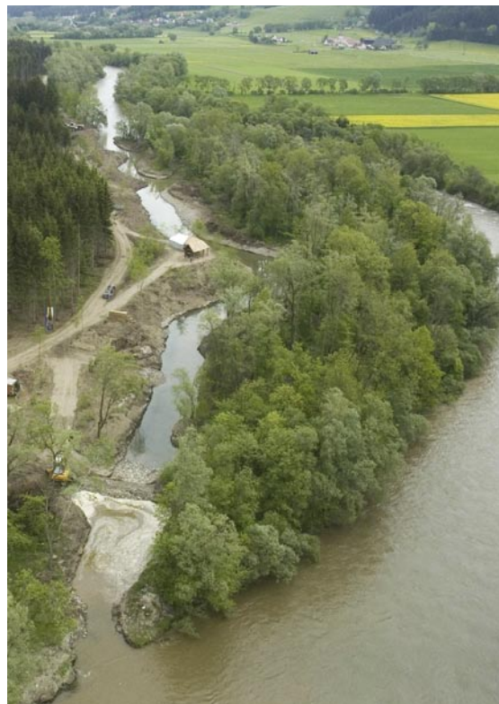
Altarmbindung Weyern-Au-Maßnahme im Zuge des LIFE-Projektes „Obere Mur“
