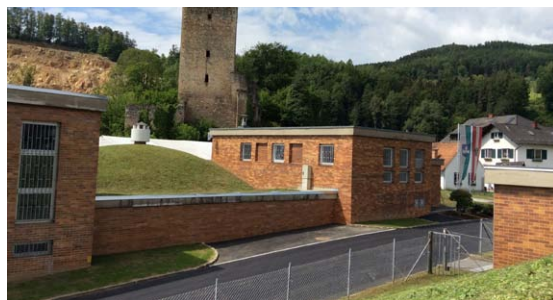
Abb. 19: Wasserversorgungsanlage in Sturmberg
