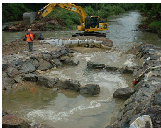
Abb. 2: Bauzustand Raab bei km 244,36 – Ertlermühle, Juni 2014
