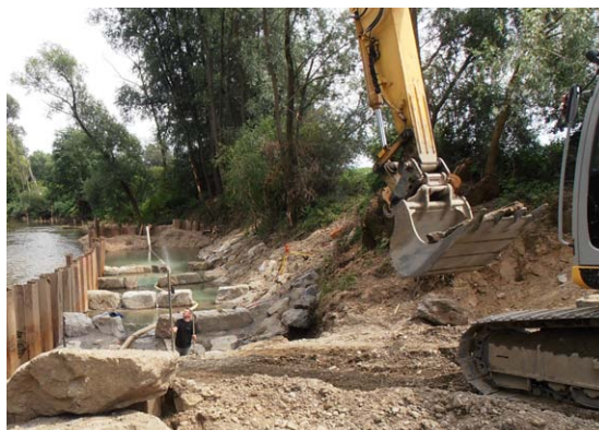
Abb. 1: Bauzustand Raab bei km 255,90 – Sohlstufe Fladnitz, Juni 2015
