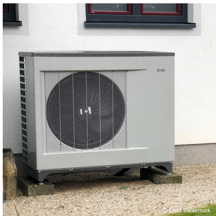
Abbildung: Wärmepumpe im Freibereich
