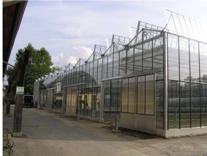
Abbildung 58: Das Cabriohaus mit geöffnetem Dach
