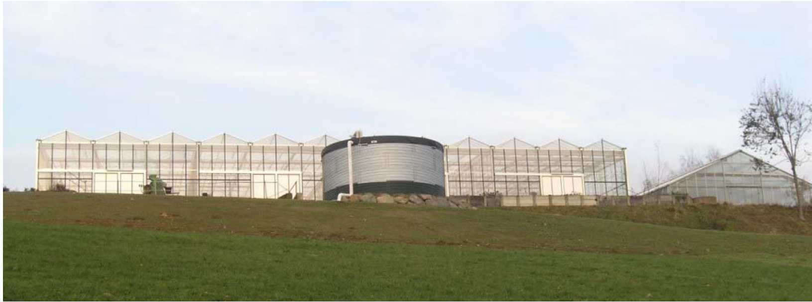
Abbildung 59: Ansicht Südseite (im Vordergrund: Regenwasserzisterne mit 90 m 3 Fassungsvermögen; rechts: Glashaus aus dem Altbestand)
