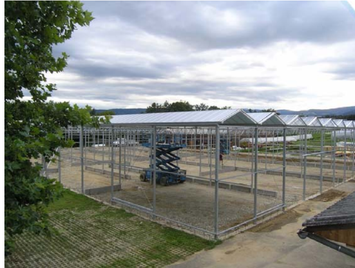
Abbildung 56: Die Überdachung folgte Ende Juli 2008
