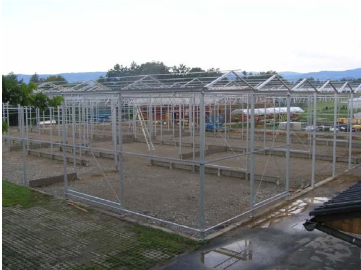
Abbildung 55: das Gerüst steht (Mitte Juli 2008)
