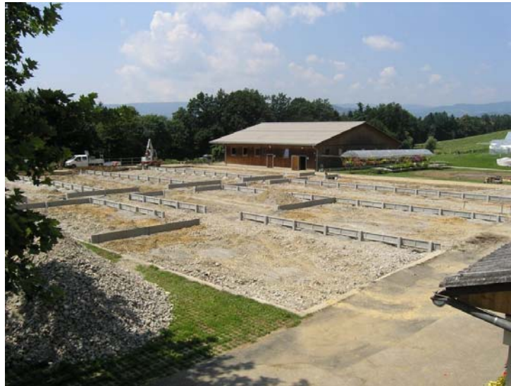
Abbildung 54: Fundamente für das Gerüst (Anfang Juli 2008)
