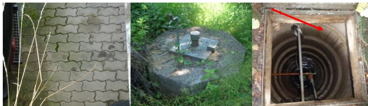
Abbildung 19: Ölflecken und Rigol im Einzugsbereich der betroffenen Messstelle sowie Brunnenschacht
