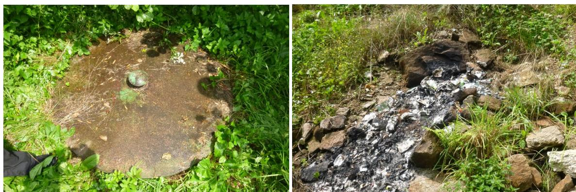
**Abbildung 18: nicht tagwasserdichter Sammelschacht und Brandstelle in unmittelbarer Nähe dazu**
