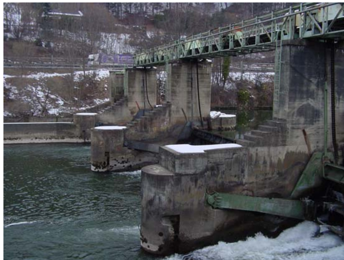
Abbildung 2: Wehranlage, Ansicht vom linken Ufer
