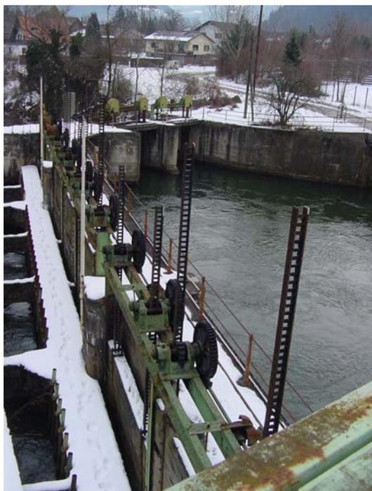
Abbildung 4: Einlauf OW Kanal mit Grobrechen und Schützentafeln
