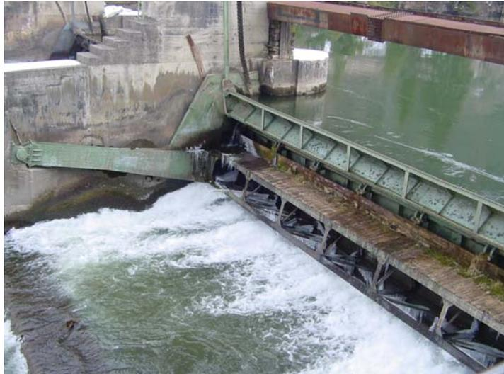
*Abbildung 3: Drucksegment mit aufgesetzter Klappe*
