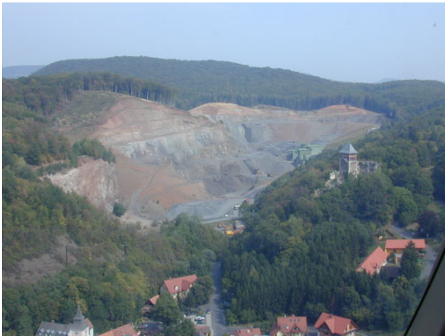
Abbildung 2: Blick in Richtung Norden auf den bestehenden Steinbruch, im Westen ist der Erweiterungsbereich ersichtlich
