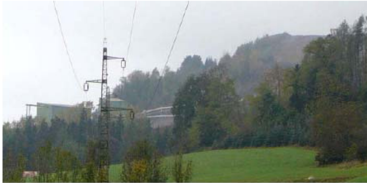
Bild 2 zeigt die Aufbereitungsanlage
