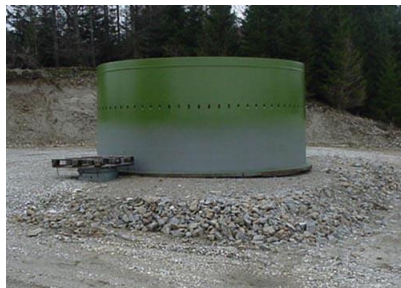
Abbildung 9: ENERCON Fundamentsektion
