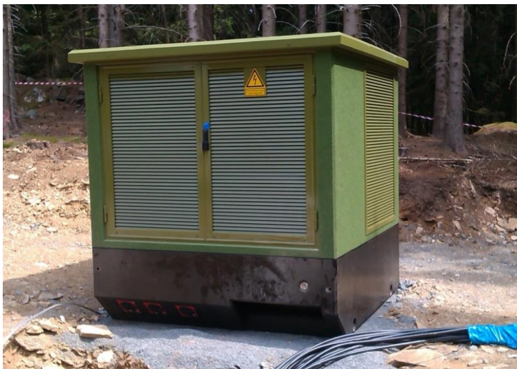
Abbildung 7: Transformator-Station
