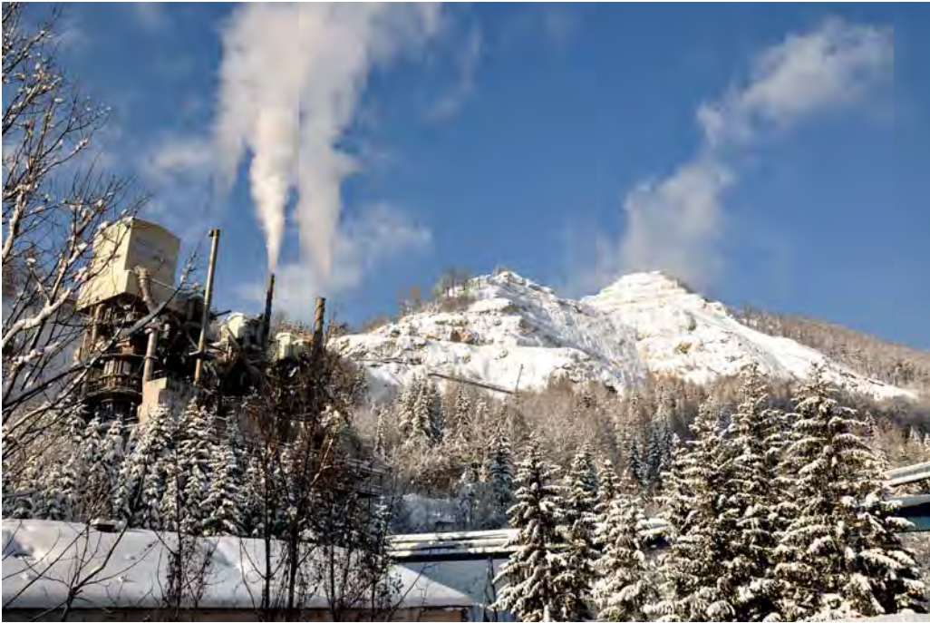
Abb. 91. Kalkwerk Steyrling: Öfen und Steinbruch (Foto: voestalpine Stahl GmbH).
