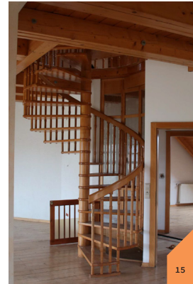
Diese Wendeltreppe wurde wieder verwendet, nachdem sie einer Prüfung und Reparatur unterzogen wurde.
