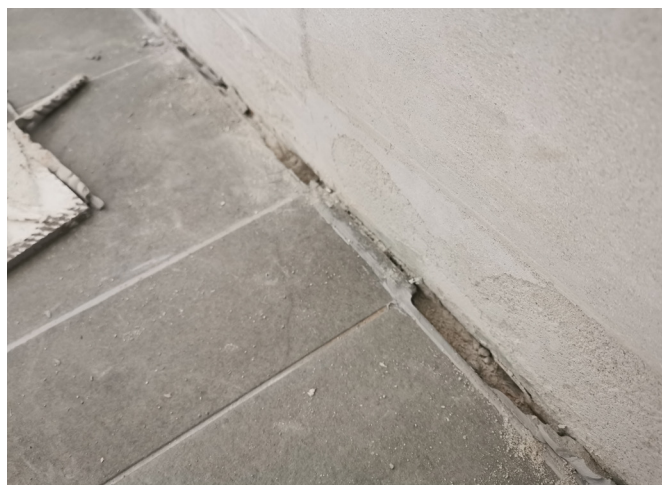
Nicht ordnungsgemäß ausgeführte Trennfuge in einem Stiegenhaus. © ABT15, Referat Lärm- und Strahlenschutz
