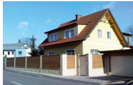
Abb 10: Lärmschutz im Selbstbau.
