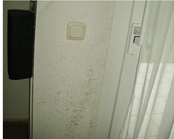
*Anstehendes Niederschlagswasser auf einer Balkonplatte verursacht einen vertikalen Feuchtigkeitstransport im Mauerwerk.*
