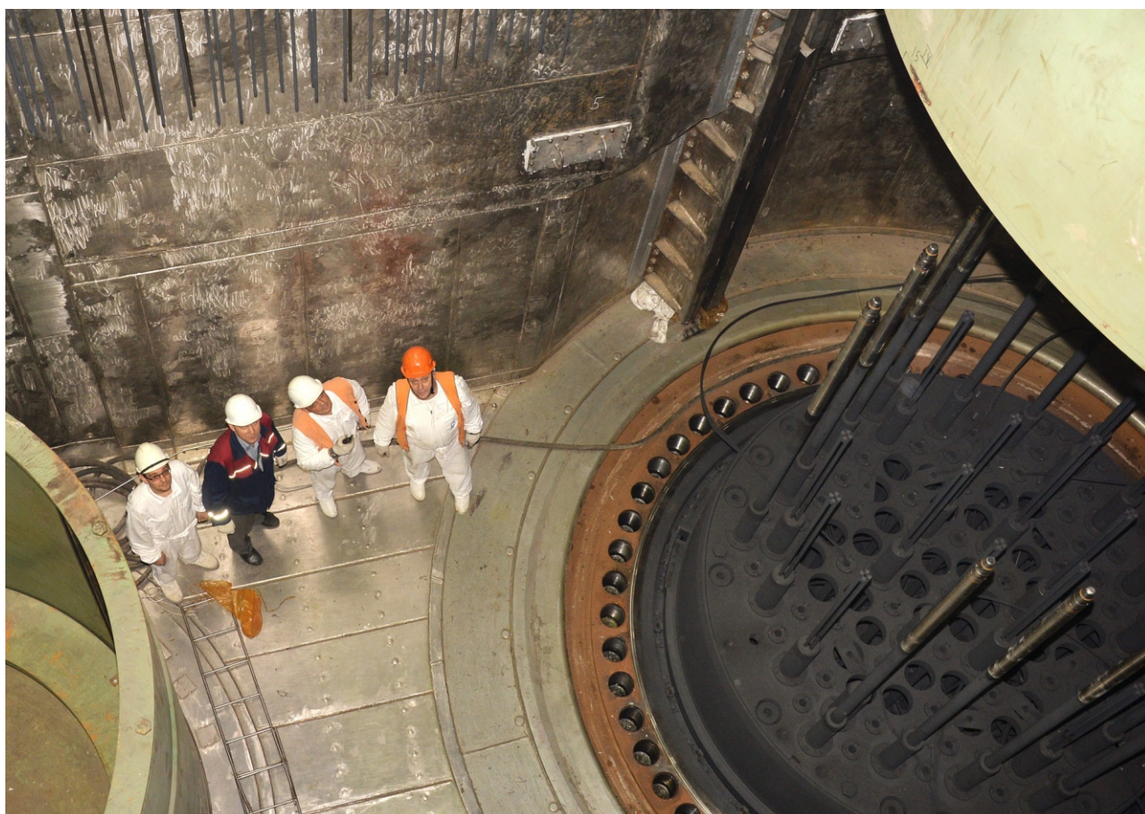
Inspektionsarbeiten am Reaktordruckbehälter; © Pixabay
