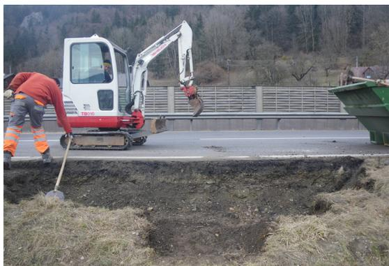
Abb 2 - Bodenaushub von kontaminiertem Material
