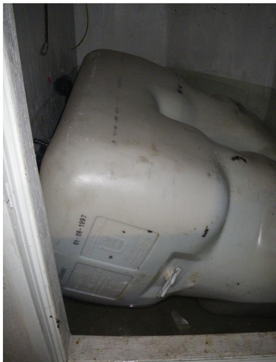
Abb 4 - Umgekippter Öltank im Öllageraum
