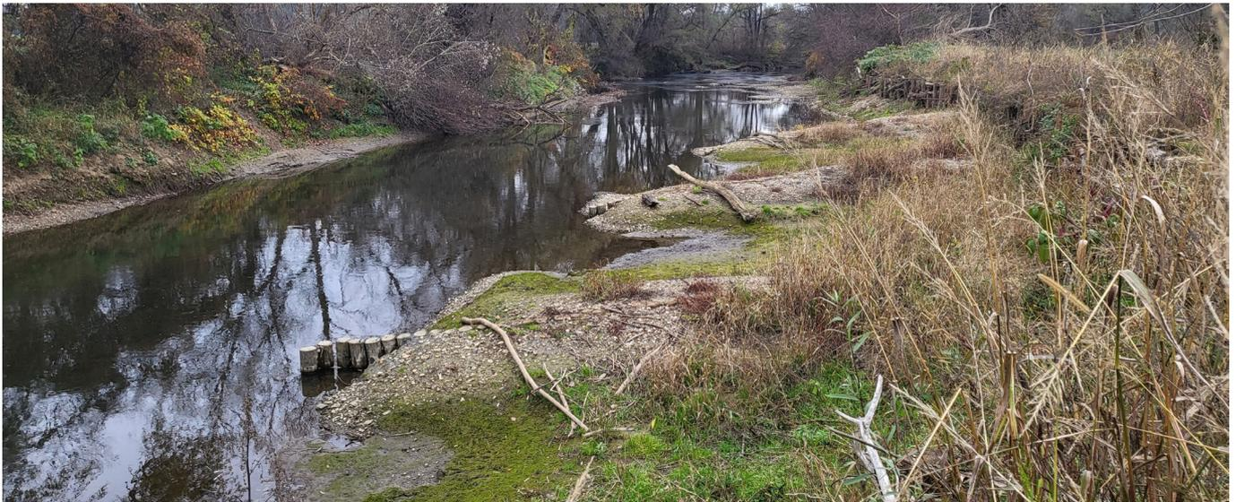
Sanierung eines rechtsufrigen Uferanrisses an der Kainach/Höhe Weitendorf mittels vorgelagerter inklinanter Bühnen aus Holzpiloten und ausschlagfähigen Gehölzen im oberen Böschungsbereich (vorher oben, nachher unten), © IB Parthl
