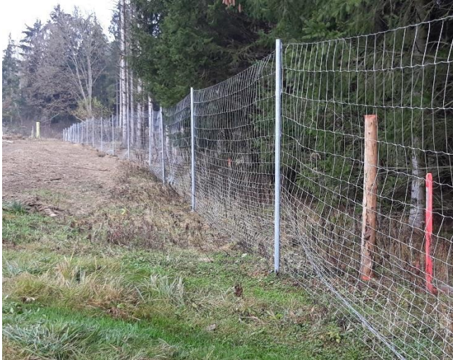
Abbildung 7: Beispiel einer Wild-sicheren Abzäunung entlang eines Betriebsweges
