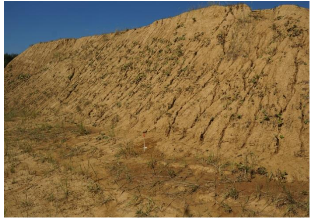
Abbildung 27: Steilwand im Bereich nicht abgebauter Lehmstöcke
