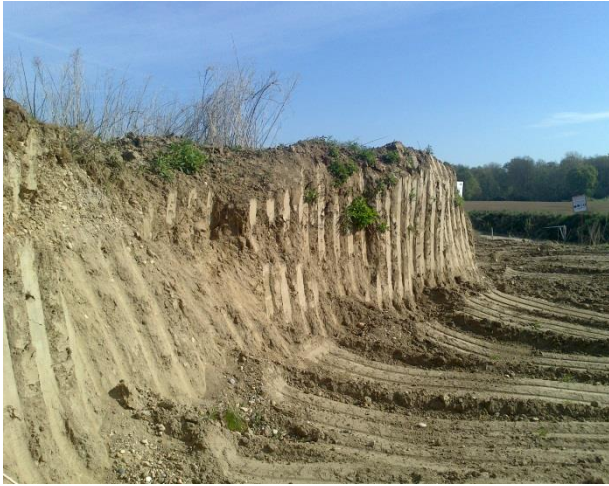
Abbildung 29: Neu hergestellte Steilwand
