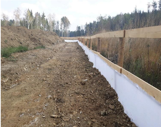
Abbildung 8: Beispiel einer amphibien- sowie reptiliendichten Abzäunung entlang eines Betriebsweges
