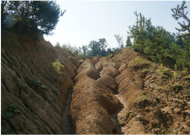
Abbildung 26: Lehm-Steilwandbereiche entlang aufgegebenem Betriebsweg
