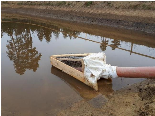
Abbildung 11: Beispiel einer Sicherung, um im Zuge einer Entwässerung Individuenverluste von Amphibien zu vermeiden.
