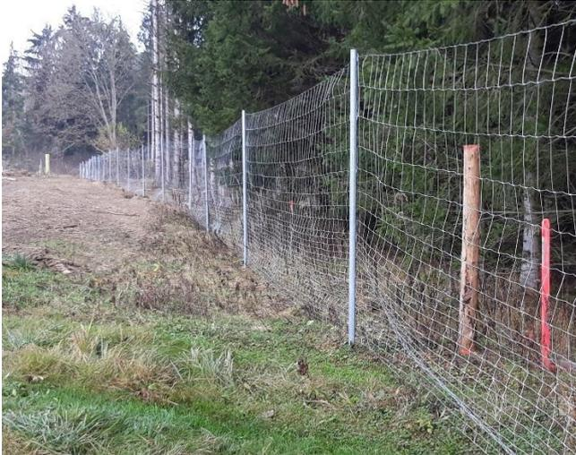
Abbildung 9: Beispiel einer Wild-sicheren Abzäunung entlang eines Betriebsweges
