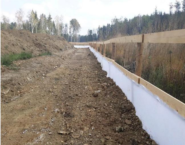
Abbildung 10: Beispiel einer amphibien- sowie reptiliendichten Abzäunung entlang eines Betriebsweges
