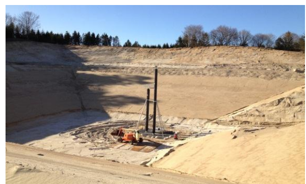
Abbildung 14: Dronninglund Wärmespeicher in Bau (Bildquelle: Dronninglund Fernwärme)
