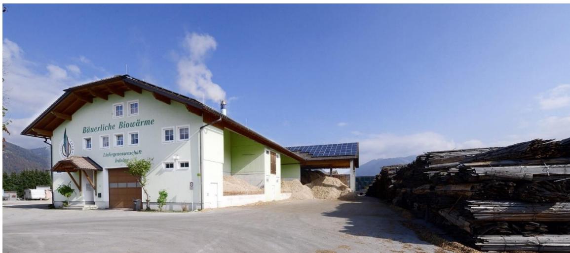
Abbildung 1: Biowärme Irdning mit Holzlager © Bäuerliche Biowärmelieferungsgenossenschaft Irdning eGen
