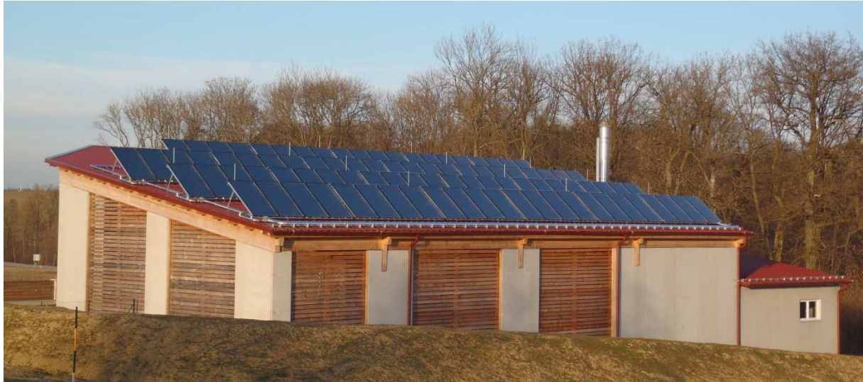
Abbildung 19: Heizwerk der Nahwärme Weichstetten (Quelle: AEE INTEC)
