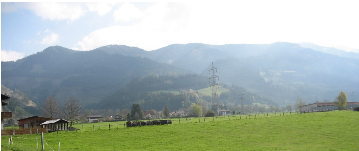
Abbildung 40: Talquerung Leitungstrasse bei Gaishorn
