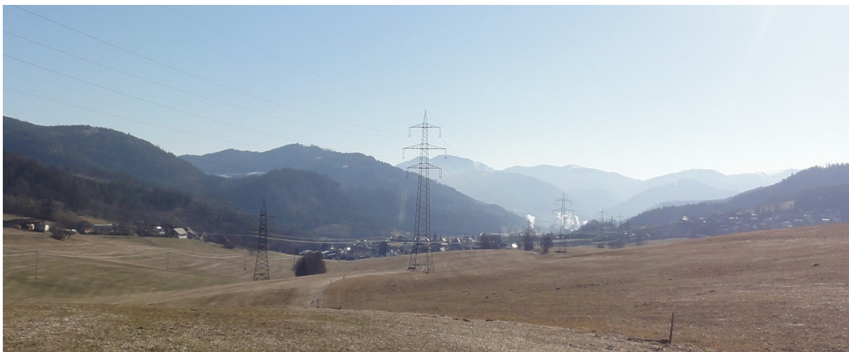
Abbildung 33: Leitungstrasse – Blick Richtung St.Peter-Freienstein
