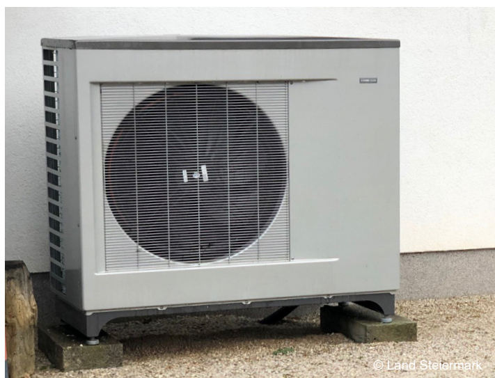
Abbildung: Wärmepumpe im Freibereich
