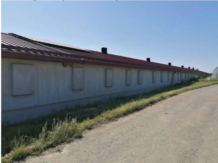
Abbildung 16: Aufnahme der Hofstelle Eberhart aus Nordwesten
