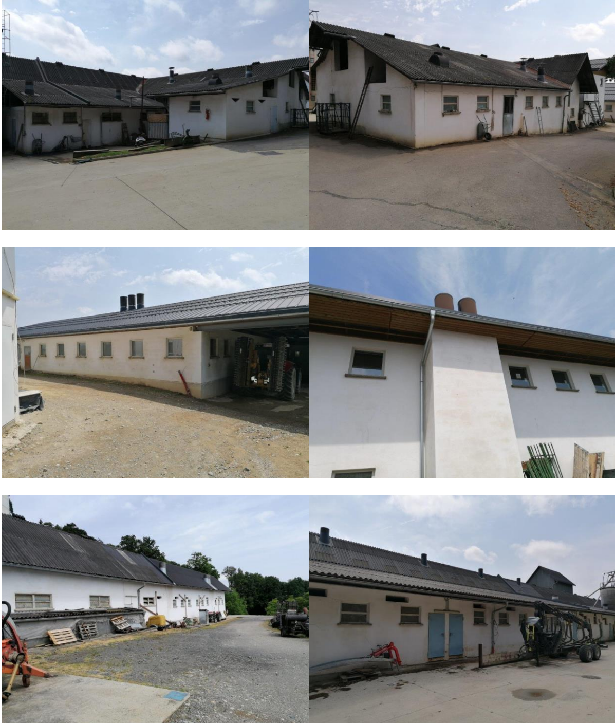
Abbildung 4: Aufnahmen an der Hofstelle Praßl (links oben: Ferkel- und Zuchtsauabteile; rechts oben: Ferkelabteile; Mitte links: Zuchtsauenstall 2004; Mitte rechts: Mastschweinestall 2007; unten links: Mastschweinestall 2001 – Südansicht; unten rechts: Mastschweinestall 2001 – Nordansicht
