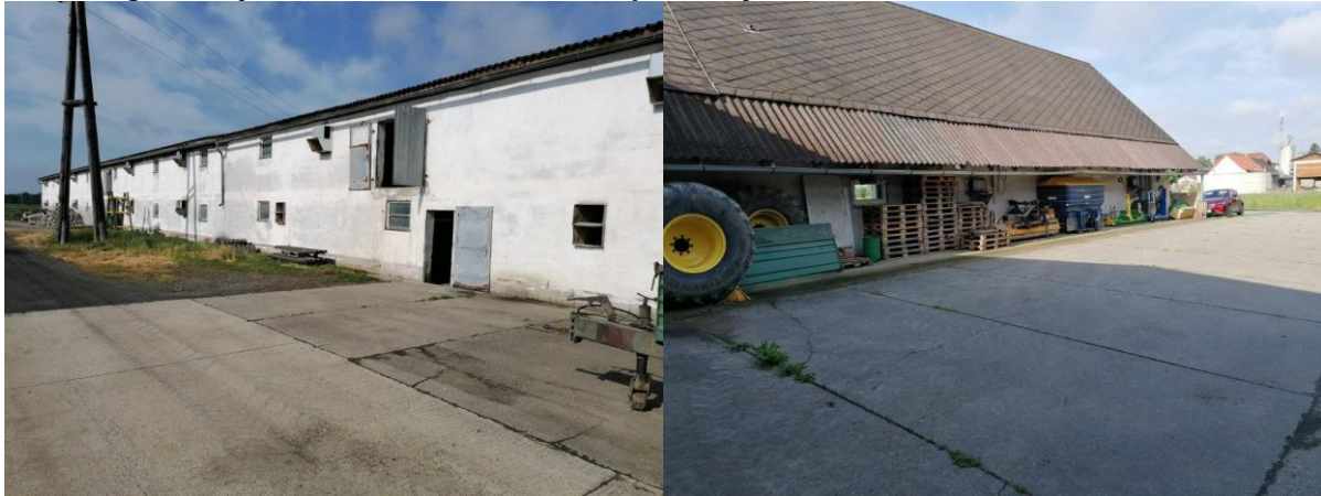
Abbildung 12: Aufnahme der beiden Ställe Großschädl jeweils aus Nordosten
