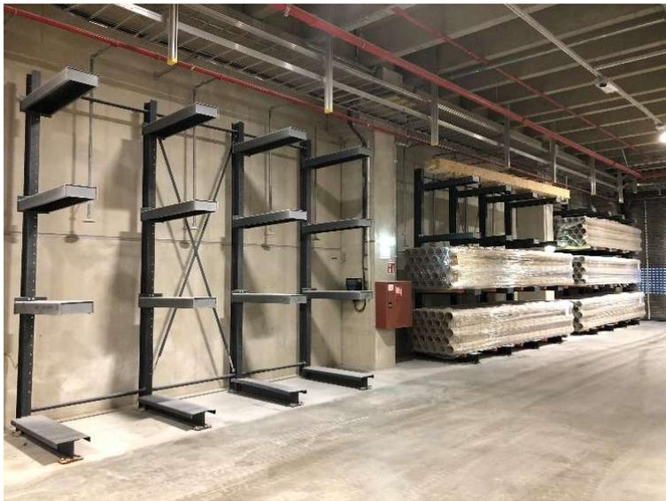
Zur optimalen Platz Ausnutzung im Kellerbereich unter der Ausrüstung (Rollenschneider und Rollenverpackung) und zur schonenden Lagerung der unterschiedlichen Hülsenpakete werden zur normalen Boden Lagerung auch freistehende Kragarm Regale installiert.
