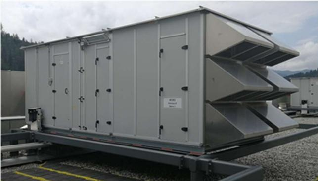
Kompaktanlage für Außenaufstellung, die Wand-, Decken- und Bodenelemente sind aus doppelschaligen verz. Stahlglattblechen mit dazwischenliegender Mineralwollisolierung, nicht brennbar nach DIN 4102.
