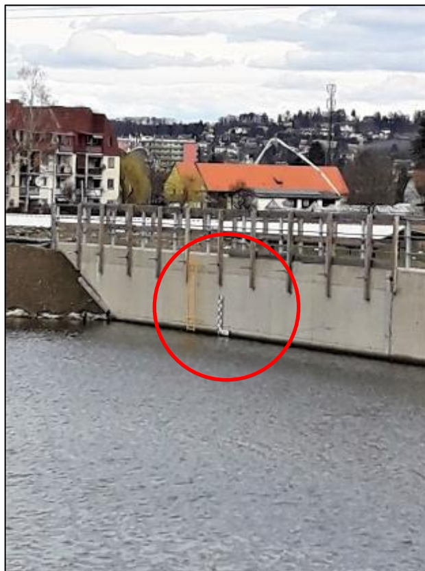
Abbildung 62 : Die Staumaße (rot markiert) wurden im Stauraum gut sichtbar am rechten und linken Ufer angebracht. (04.03.2020)
