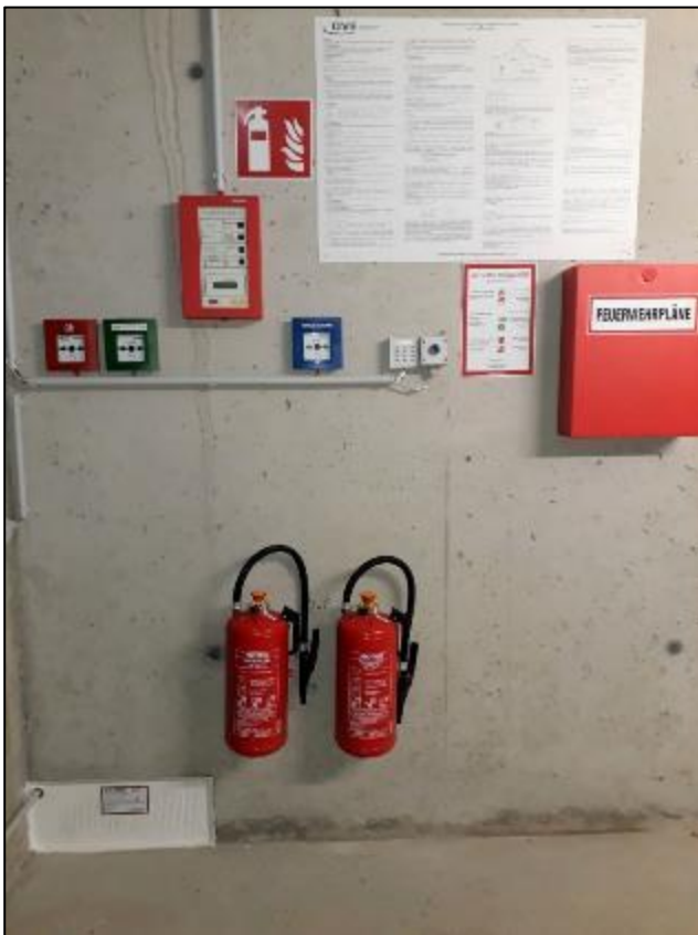
Abbildung 66: Im Betriebsgebäude montierte tragbare Feuerlöscher für den Einsatz bei Brandklassen A,B,C.
