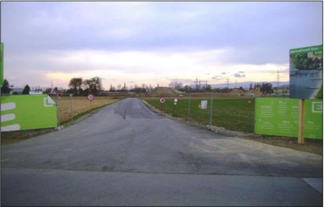
Abbildung 52: Sämtliche asphaltierte Fahrwege und Zufahrten wurden mit einer Geschwindigkeitsbegrenzung von 30km/h beschildert. (23.03.2017)
