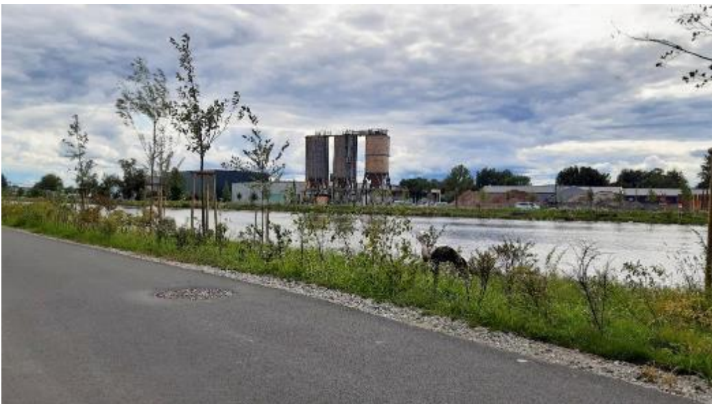
Abbildung 78: Ökozone bei der Seichtwasserzone Grünanger in der Errichtungsphase mit Strukturierungen und dichter Heckenbepflanzung.
