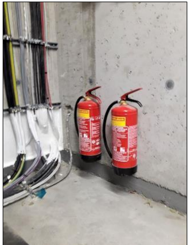
Abbildung 66: Im Betriebsgebäude montierte tragbare Feuerlöscher für den Einsatz bei Brandklassen A,B,C.
