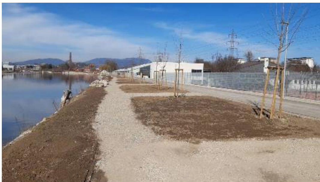
Abbildung 152: Durch Errichtung einer Stützmauer (rechts im Bild) konnte die nutzbare Dammfläche verbreitert werden (Foto vom März 2021).
