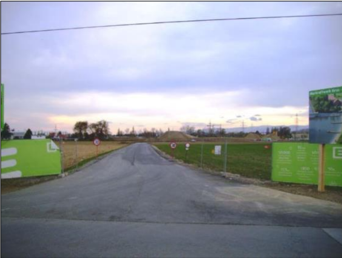
Abbildung 59: Baustellenzufahrt von Ziehrerstraße in das Baustellenareal
