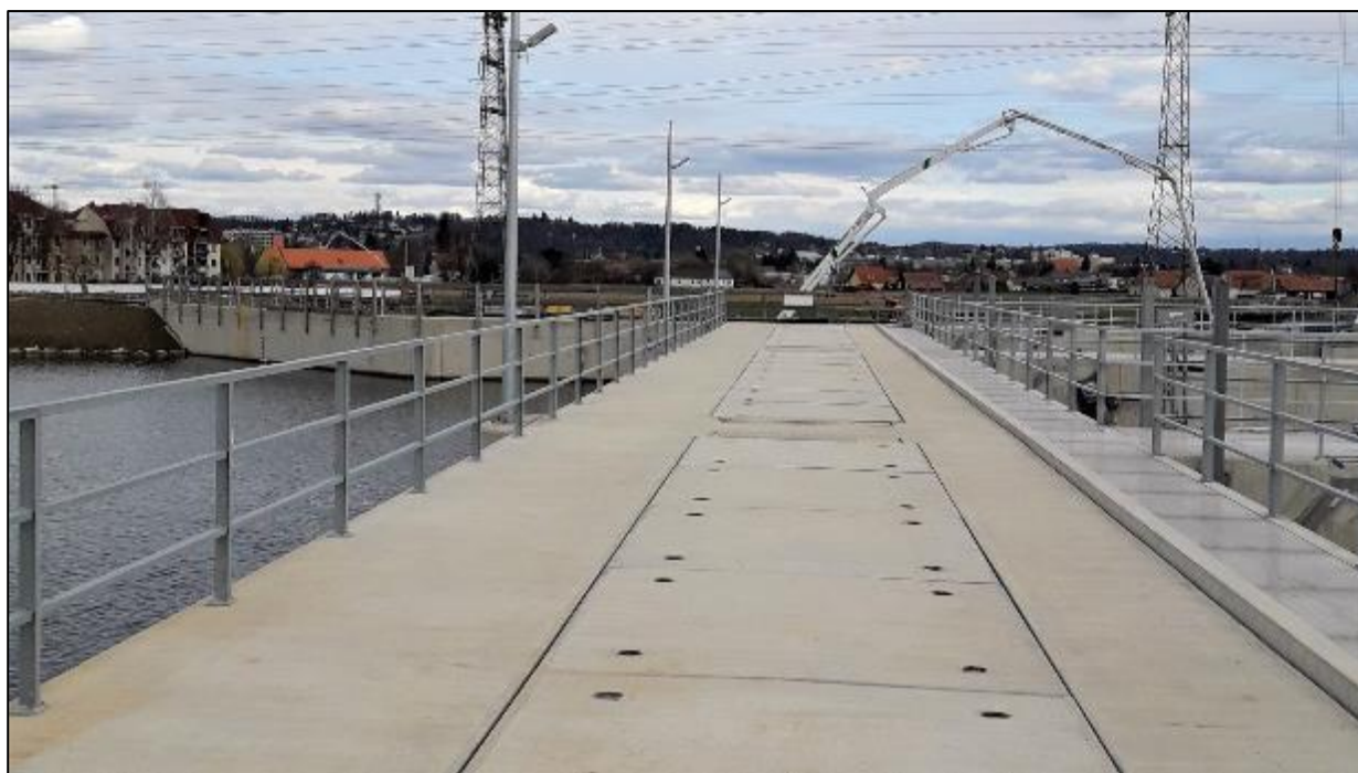
Abbildung 70: Alle absturzgefährlichen Bereiche (hier beispielhaft im Außenbereich) wurden bescheidkonform gesichert.
