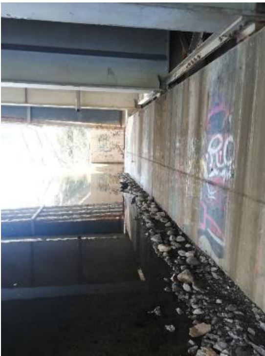
Abbildung 115: Fischotterberme bei der Bertha von Suttner Brücke am rechten Ufer. Blick Richtung Süden (Foto: September 2021)
