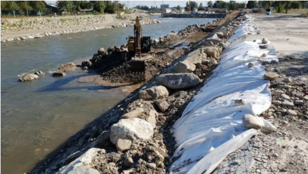
Abbildung 47: Besonders erosionsgefährdete Bereiche wurden durch Vlies gesichert (Foto: geologisch geotechnische Bauaufsicht)
