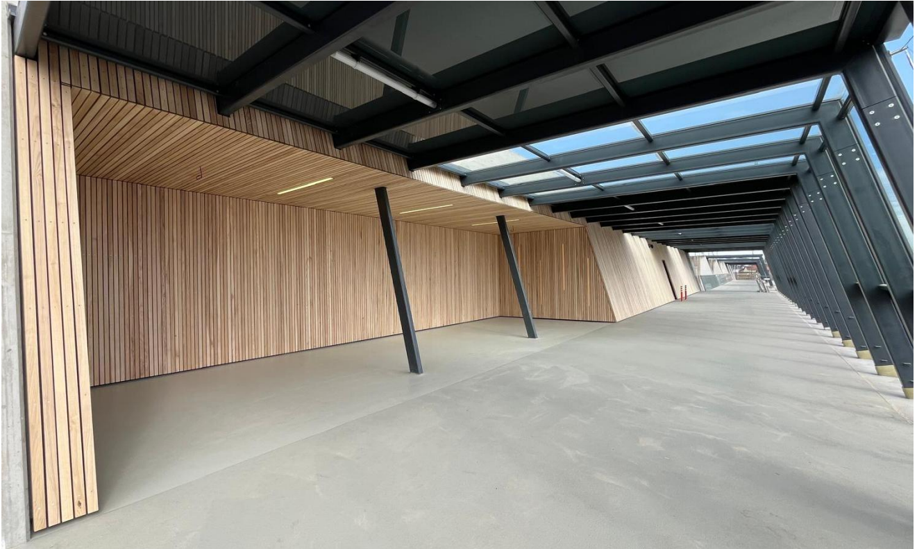
Abbildung 126: Fuß- und Radwegbrücke über das Kraftwerk (Foto: 24.03.2025)
