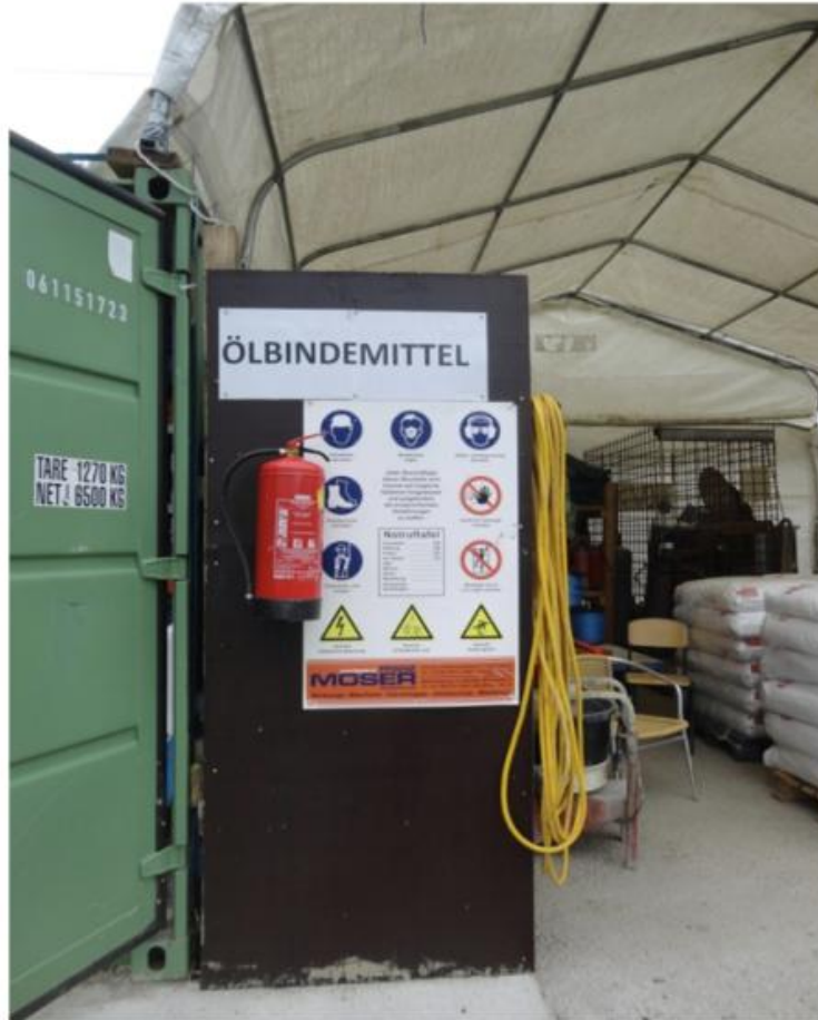
Abbildung 62: Container für Ölbindemittel im Bereich der Baustelleneinrichtungsfläche
