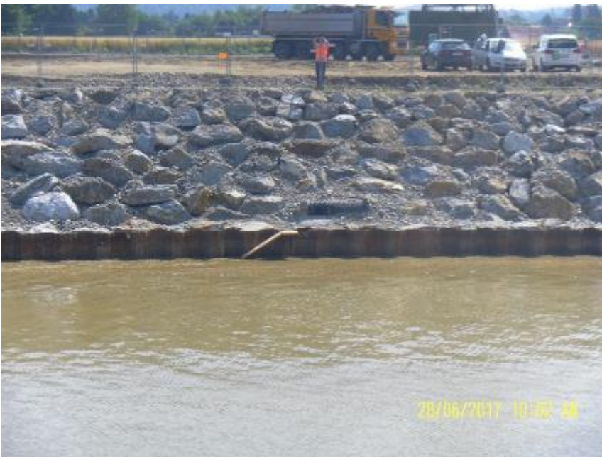
Abbildung 29: Fischotterausstieg und künstlich angelegte Höhle in der Bauphase (Foto: 28.06.2017)
