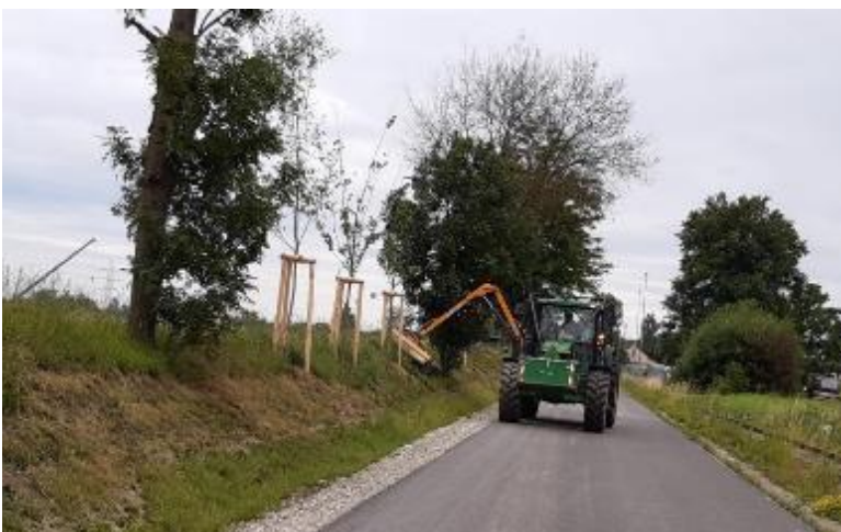
Abbildung 14: Mäharbeiten am rechtsufrigen Damm im Oberwasser des Murkraftwerks Graz.
