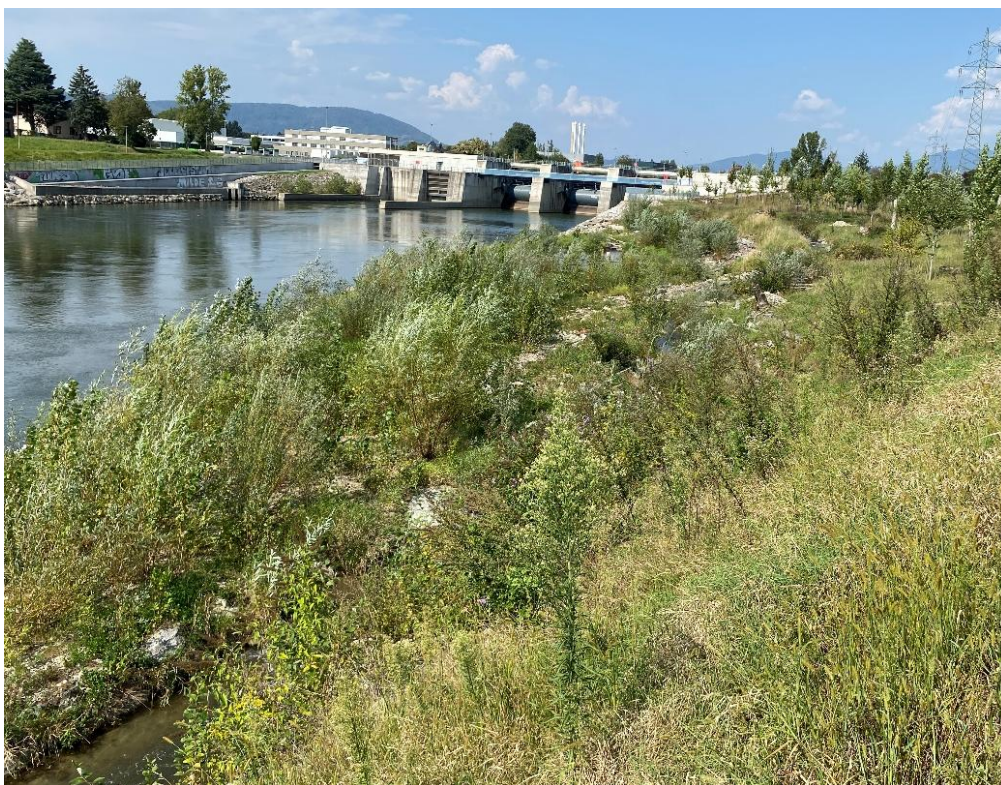
Abbildung 84: Kraftwerkspark Blickrichtung Norden, Buschweiden/Weichholzau (Foto: 03.09.2024)
