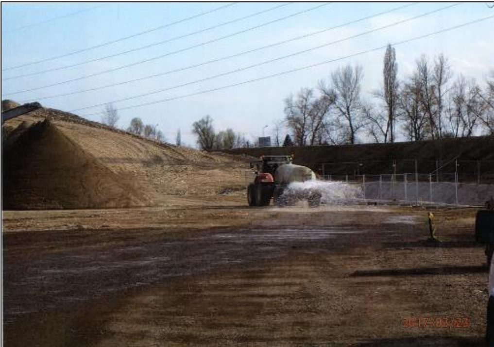
Abbildung 53: Zur Staubbildung neigende Oberflächen wurden laufend befeuchtet. (23.03.2017)
