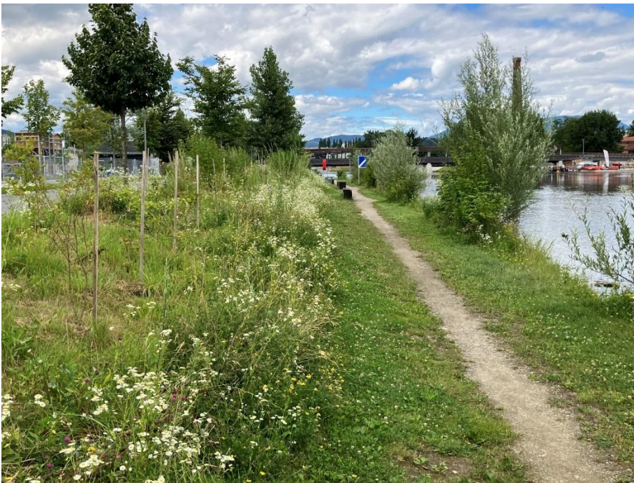
Abbildung 140: Berme linksufrig flussab des Puchstegs (Foto: Juli 2024)
