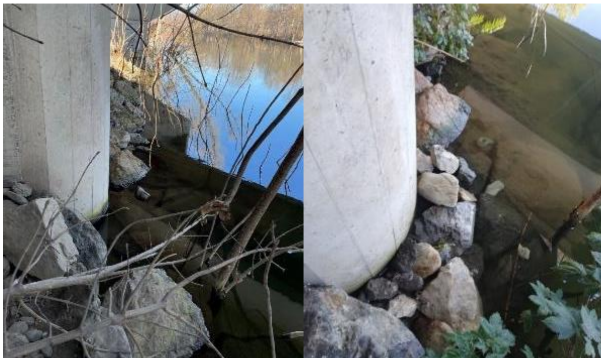
Abbildung 116: Blickrichtung Nord Ost flussauf, links: vor der Auffüllung, rechts: nach dem Auffüllen der Berme
