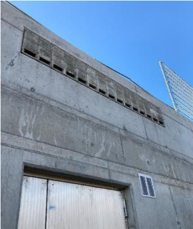
Abbildung 113 Fledermausziegel im Kaskadenbauwerk KS5 (Foto: 21.12.2021)
