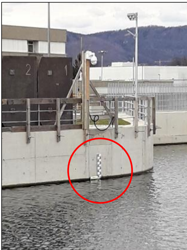
Abbildung 62 : Die Staumaße (rot markiert) wurden im Stauraum gut sichtbar am rechten und linken Ufer angebracht. (04.03.2020)
