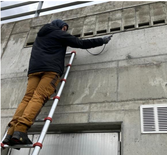
Abbildung 114: Kontrolle der Fledermausziegel (Foto: 21.11.2024)
