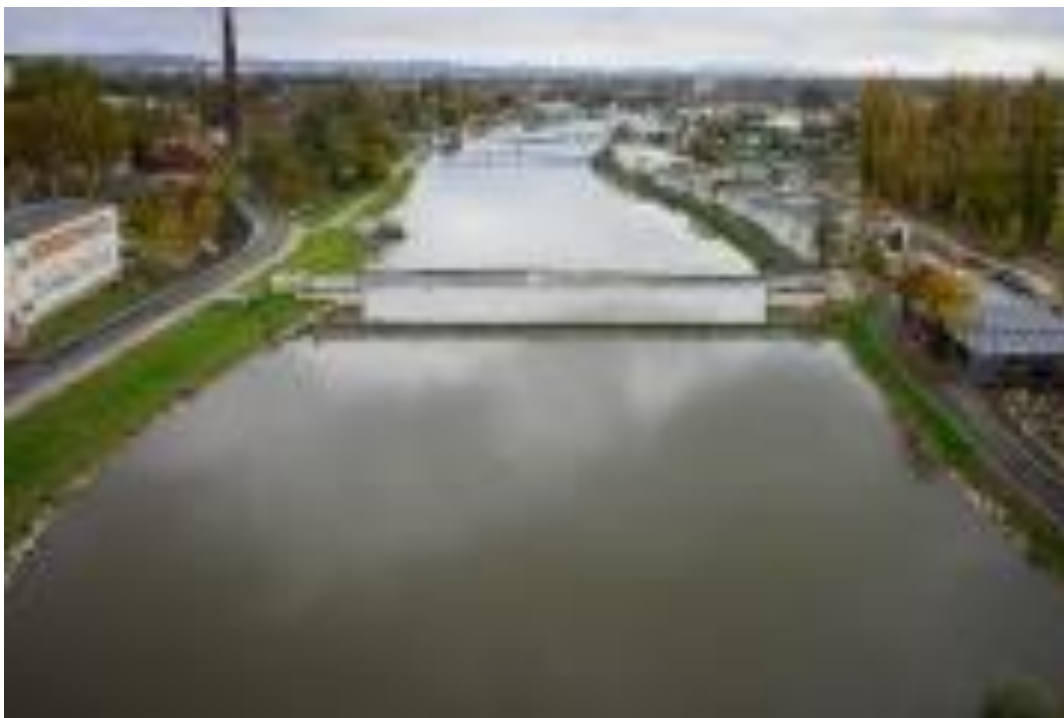
Abbildung 149: Mediensteg mit Blick Richtung Norden, gut erkennbar die beiden neu errichteten Auflager der Brücke.
