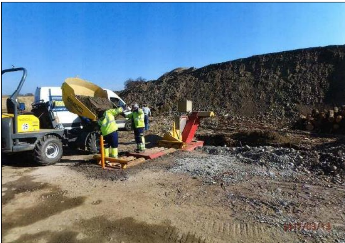
Abbildung 56: Detailaufnahme der Reifenwaschanlage bei der Zufahrt Ziehrerstraße im Zuge der Einbauarbeiten. (13.03.2017)
