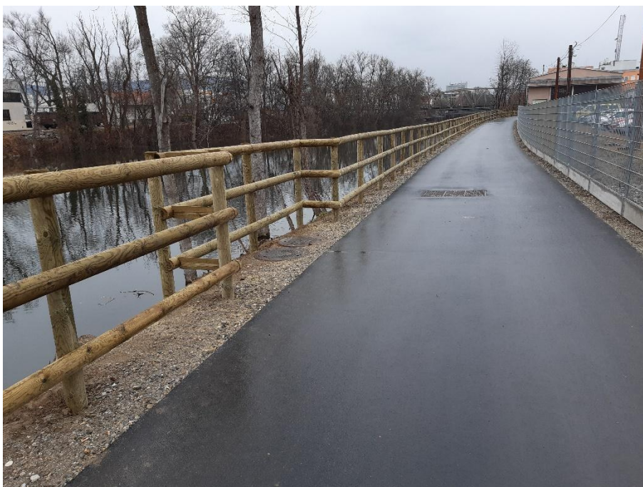
Abbildung 133: Radweg am linken Murofer, Richtung flussauf fotografiert (im Bereich der ÖBB-Brücke, Foto: 19.02.2020)
