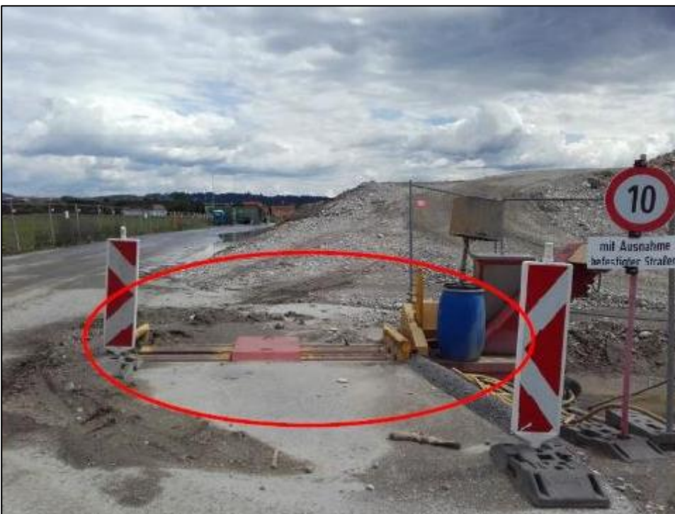
Abbildung 51: Auf unbefestigten Wegen wurde die Höchstgeschwindigkeit von 10km/h ausgeschildert. Foto von der Zufahrt Ziehrerstraße, im Bereich der Reifenwaschanlage (markiert) vor Inbetriebnahme. (27.03.2017)
