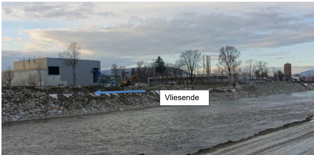
Abbildung 33: Vliesverlegung in der Bauphase vor dem Aufstau. Nach Aufstau befindet sich kein Vlies in der Böschung oberhalb der Wasseranschlaglinie. (Foto: 29.01.2019)
