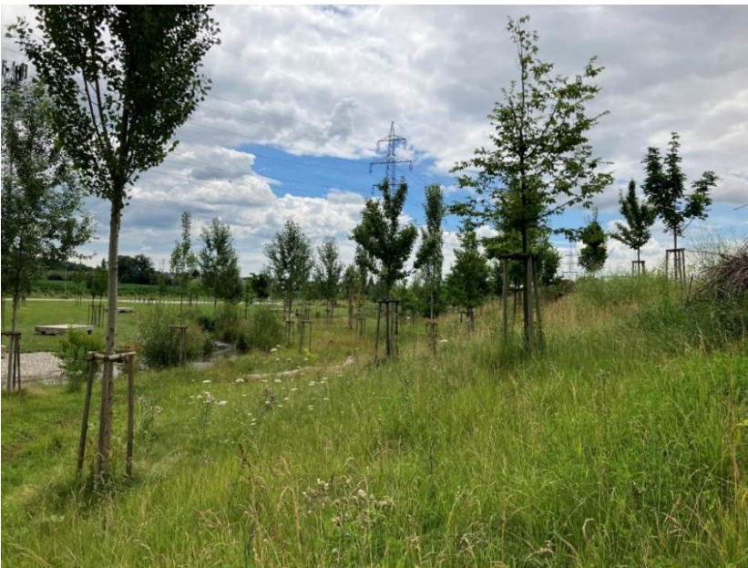
Abbildung 86: Luftseitige Böschung im Kraftwerkspark mit Blick Richtung Freizeitbereich (Foto vom Juli 2024)
