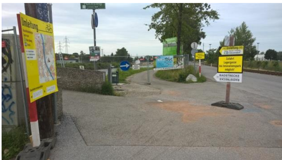
Abbildung 61 : Radwegumleitungen wurden in der Bauphase auf die unbedingt notwendige Zeit beschränkt und gut sichtbar beschildert. (Foto: Bereich Lagergasse)
