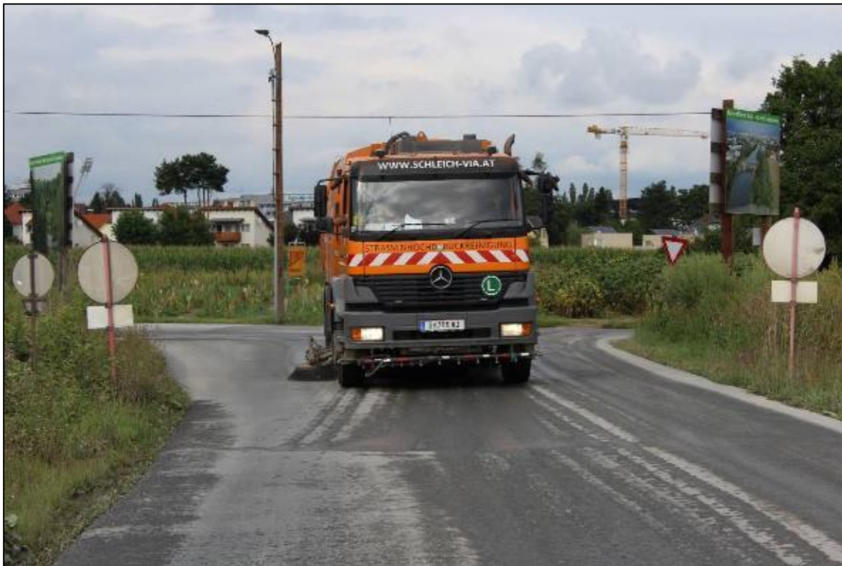
Abbildung 57: Die Übergänge der Baustellenzufahrt ins öffentliche Straßennetz wurden laufend gereinigt. (08.08.2019)
