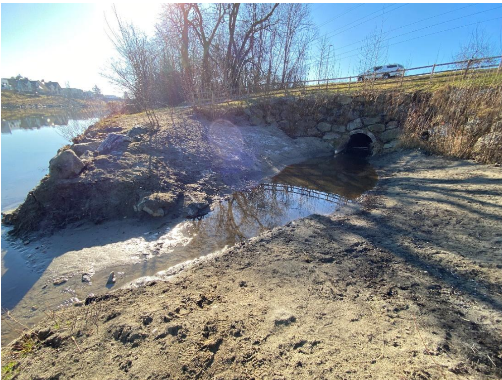
Abbildung 145: Durchlass zum Aubiotop, mit instandgesetzter Sohle (Foto: 30.01.2025)
