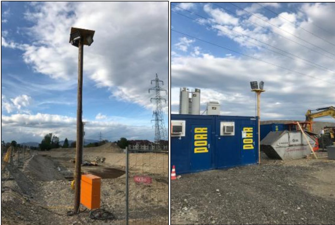
Abbildung 95: Links 3 LED-Strahler mit Abschirmung nach oben im Bereich der Schlitzwandarbeiten und rechts 2 LED-Strahler im Bereich Baucontainer.
