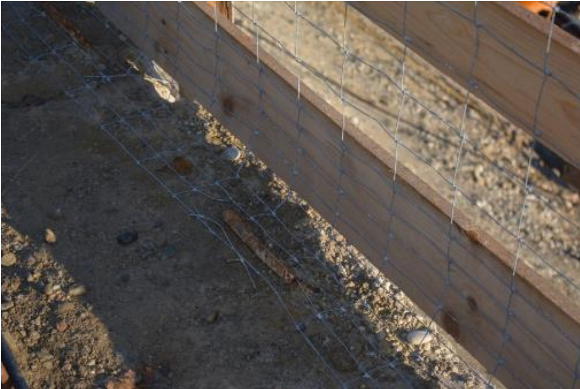
Abbildung 93: Kleintiersicherer Bodenschluss (Maschenweite 5 x 15 cm) (Foto: 24.11.2017)
