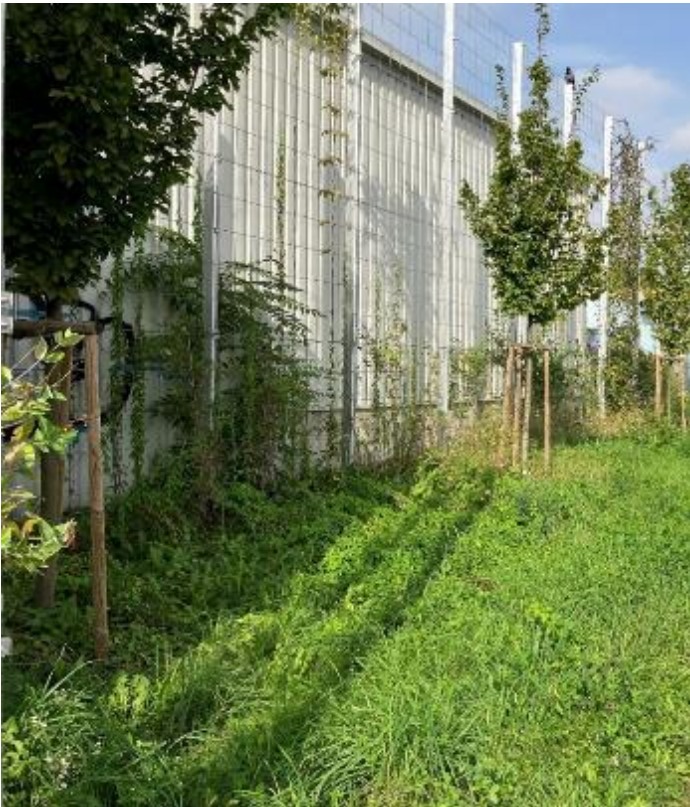
Abbildung 146: Fassadenbegrünung im Bereich des Kanalbetriebes der Holding Graz (Foto: 18.09.2023)
