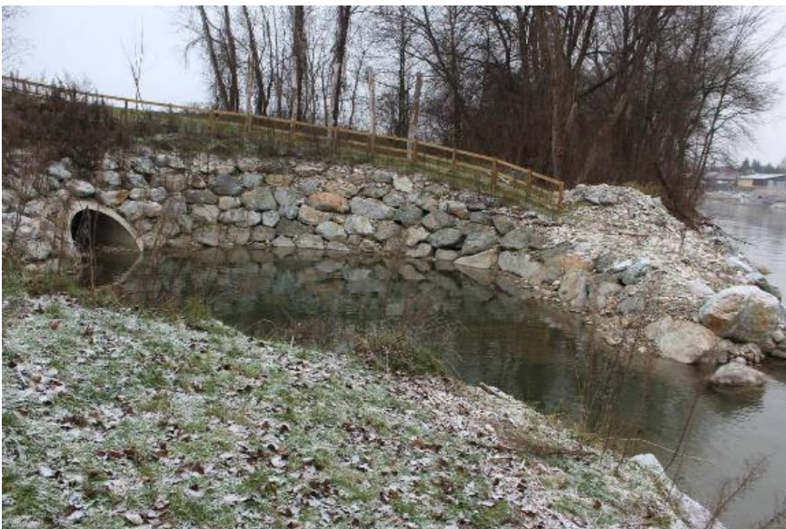
Abbildung 143: Murseitig wurden Einlauf und Auslauf fischfreundlich in Form einer Bucht ausgestaltet (Foto:13.12.2019).
