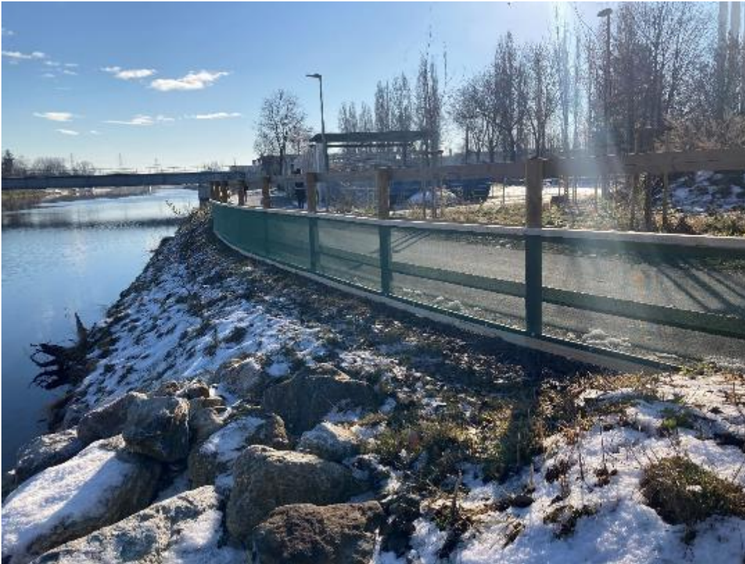
Abbildung 75: Der Überstiegsschutz wurde im Bereich des grünen Bandes auf eine Länge von 30m angebracht.
