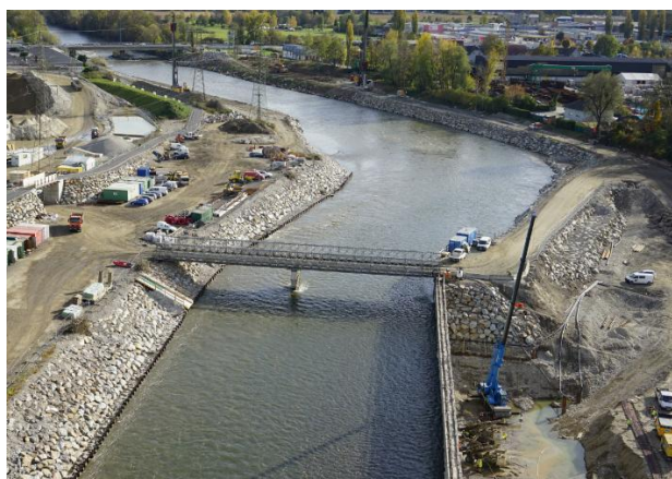
Abbildung 123: Baubrücke über die Murumleitung
