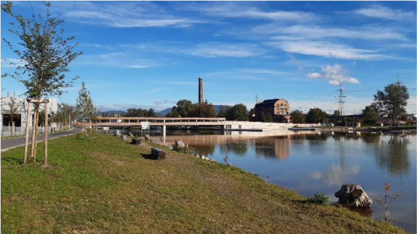
Abbildung 148: Aufgeweitetes rechtes Murufer unterhalb des Puchstegs Neu (Foto: September 2020)
