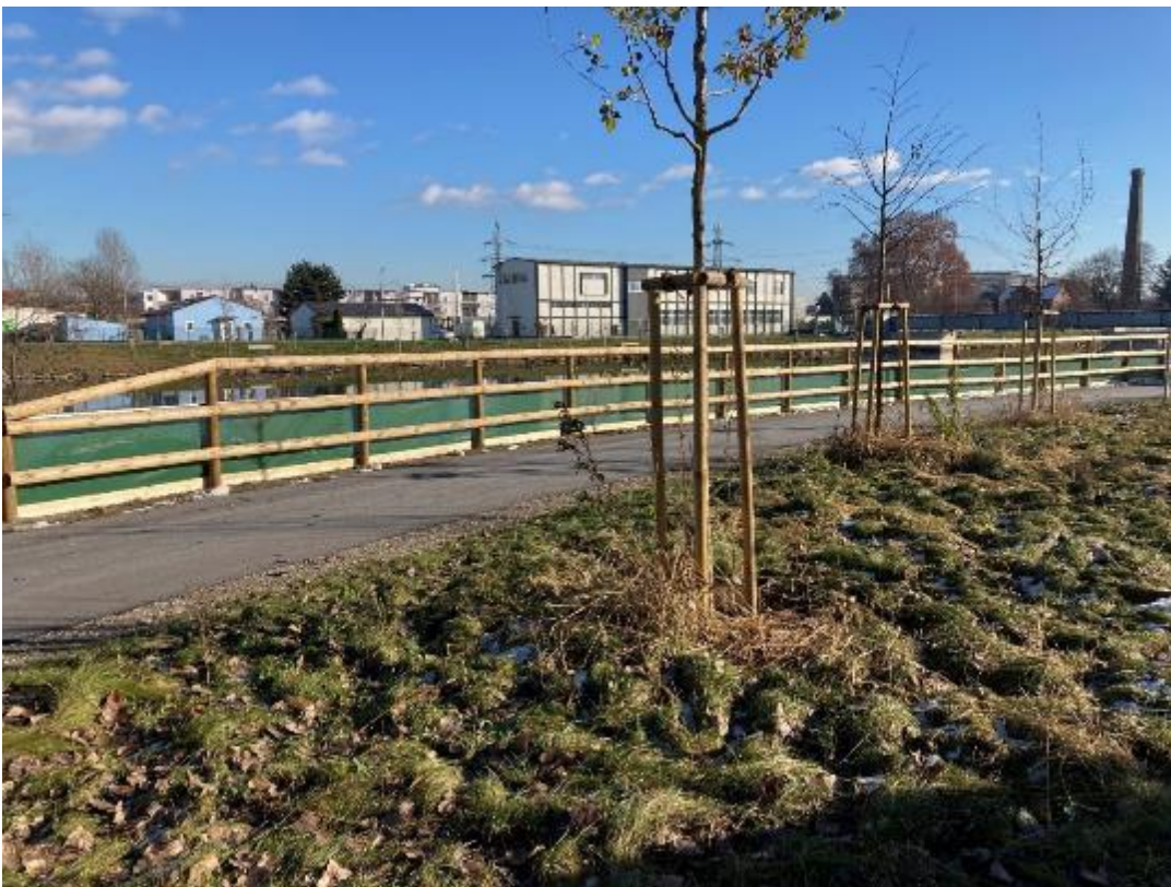
Abbildung 74: Überstiegsschutz aus einem feinmaschigen, winddurchlässigen Textil, welches mit Holzbrettern verschraubt wurde.
