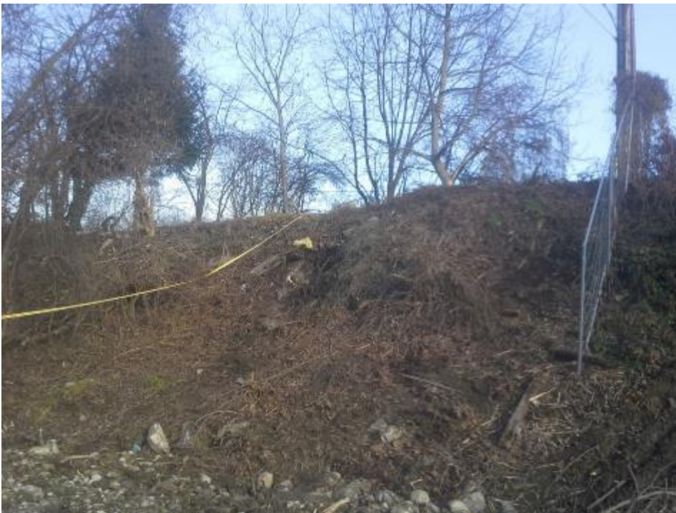
Abbildung 92: Mit einem Markierband abgegrenzter Böschungsbereich unmittelbar flussauf der Stromleitung an der Angergasse (Foto: 20.12.2017)
